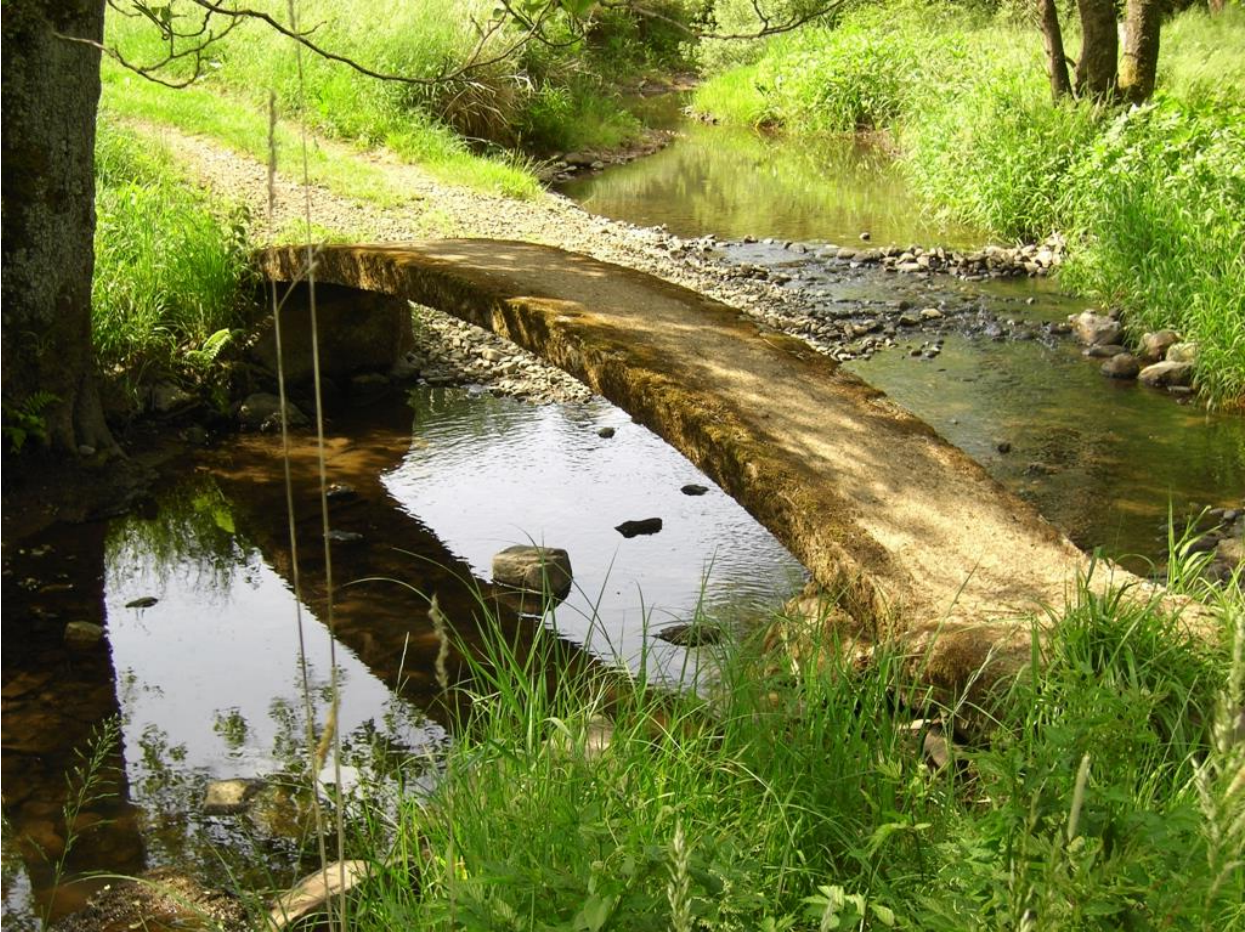
Steg aus Spannbeton / Bild: Bernd Schröder
